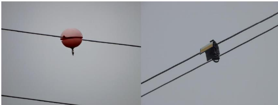
Рисунок 11 - Пример маркирующих устройств, предотвращающих столкновение птиц об провода
